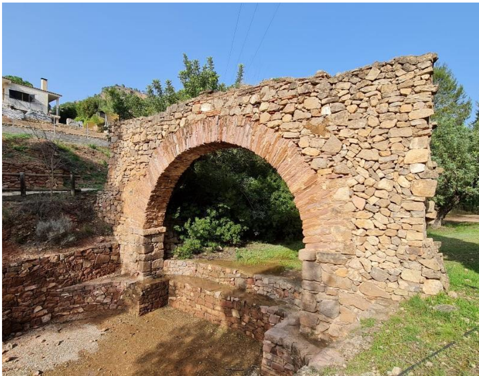
Figura 57: Acueducto de l'Arquet - Serra
